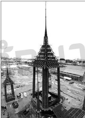
การก่อสร้างพระเมรุมาศของในหลวงรัชกาลที่ ๙ เป็นพระเมรุมาศที่มีขนาดใหญ่ที่สุดในประวัติศาสตร์ จึงใช้เหล็กรูปพรรณเพื่อสร้างความมั่นคงแข็งแรงและรองรับน้ำหนัก โดยใช้โครงสร้างฐานรากรับเสาฐานแบบแผ่กระจาย น้ำหนักแนวราบและใช้นอตยึดกับเสาพระเมรุมาศทั้ง ๔ มุม ระบบโครงสร้างดังกล่าวช่วยให้การก่อสร้างเป็นไปอย่างรวดเร็วและง่ายต่อการรื้อถอน
