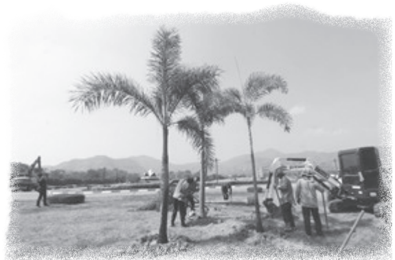
ภาพที่ ๑๔ พื้นที่หน้าอาคาร บก.ร.ร.จปร. บริเวณสนามหญ้าปีกขวา ระหว่างการดำเนินงาน
