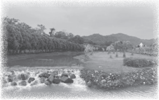
ภาพที่ ๓๑ การวางระบบน้ำและการสร้างฝายเก็บกักน้ำ
