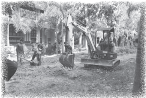
ภาพที่ ๕ ภาพพื้นที่ใช้สอยระหว่างกลุ่มอาคารกองวิชาวิศวกรรม ระหว่างการดำเนินงาน
