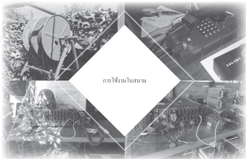
รูป การใช้งานเครื่องโทรศัพท์ ETP-1 ร่วมกับเครื่องสลับสายโทรศัพท์ทางทหาร ETE-X
