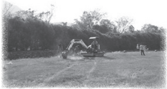
ภาพที่ ๑๗ พื้นที่หน้าอาคาร บก.ร.ร.จปร. บริเวณกึ่งกลางถนน ระหว่างการดำเนินงาน
