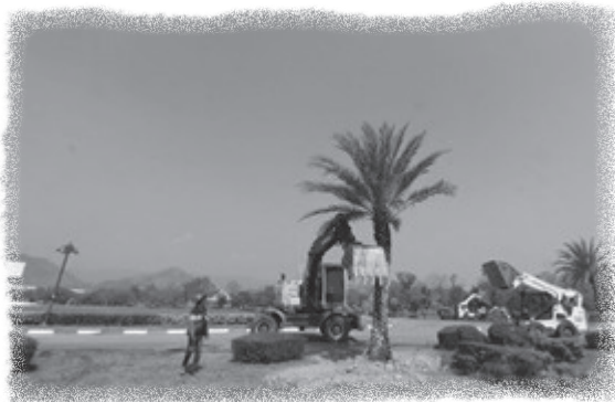
ภาพที่ ๑๑ พื้นที่หน้าอาคาร บก.ร.ร.จปร. บริเวณสนามหญ้าปักชำ ระหว่างการดำเนินงาน
