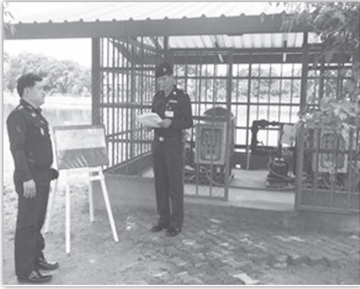
ภาพที่ ๑๒ ห้องปั๊มน้ำ
