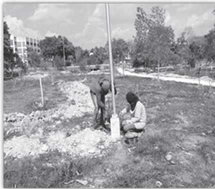
ภาพที่ ๑๔ ติดตั้งระบบน้ำแบบสปริงเกอร์เสาสูง
